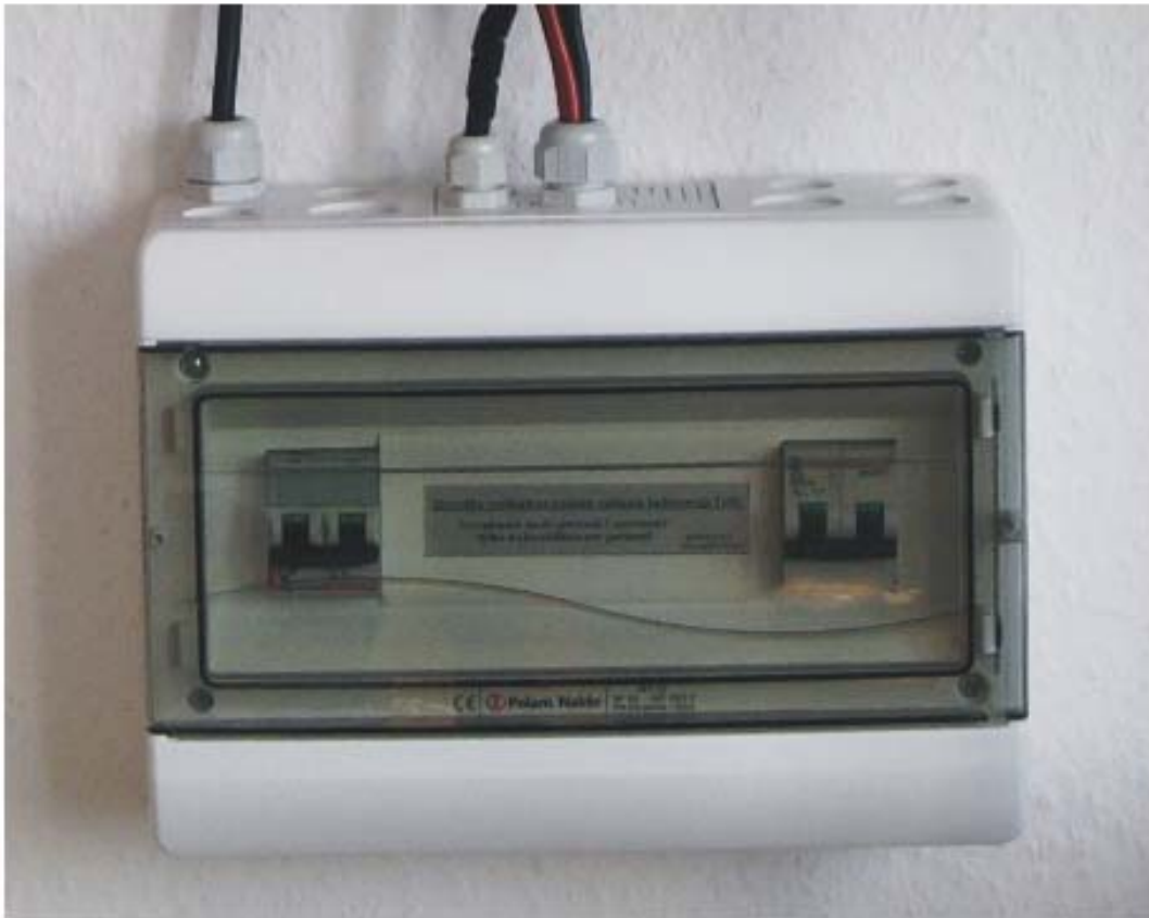
Rozdzielnica modułowa
